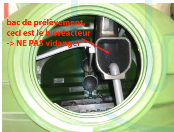
L'intérieur du bioréacteur (ne pas vidanger !)
