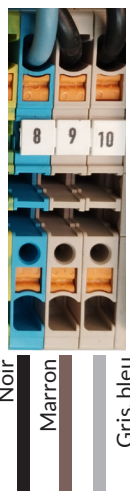
Moteurs Grundfos avant 2004
