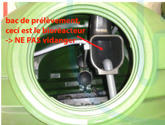
L'intérieur du bioréacteur (ne pas vidanger !)
