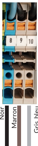
Moteurs Grundfos avant 2004
